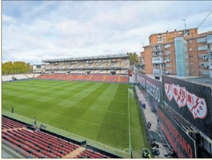
El estadio de Vallecas, antes de iniciar las obras.
